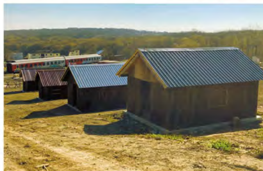
Die Ortskampfanlage am Truppenübungsplatz Bruckneudorf wurde um vier Kleinhäuser und ein Bahnhofsgelände erweitert. Foto: Bundesheer/David Feiertag
