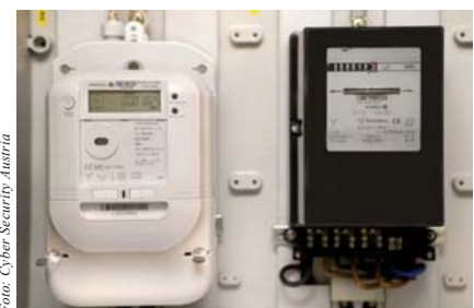
Digitaler Stromzähler - Strommesscomputer links, mechanischer Ferrariszähler rechts.
