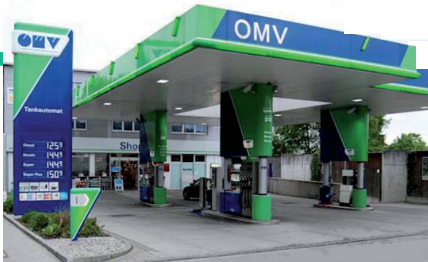
Zur Deckung des Treibstoffbedarfes genügt die Ausrüstung mit Notstromaggregaten von nur 3,5 Prozent der aktuell vorhandenen Tankstellen.
